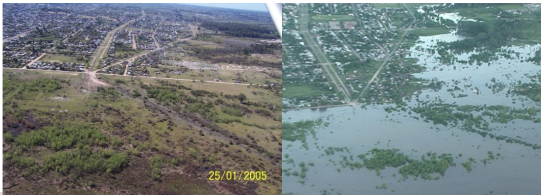
Zona del vertido del colector cloacal antes y durante evento.
